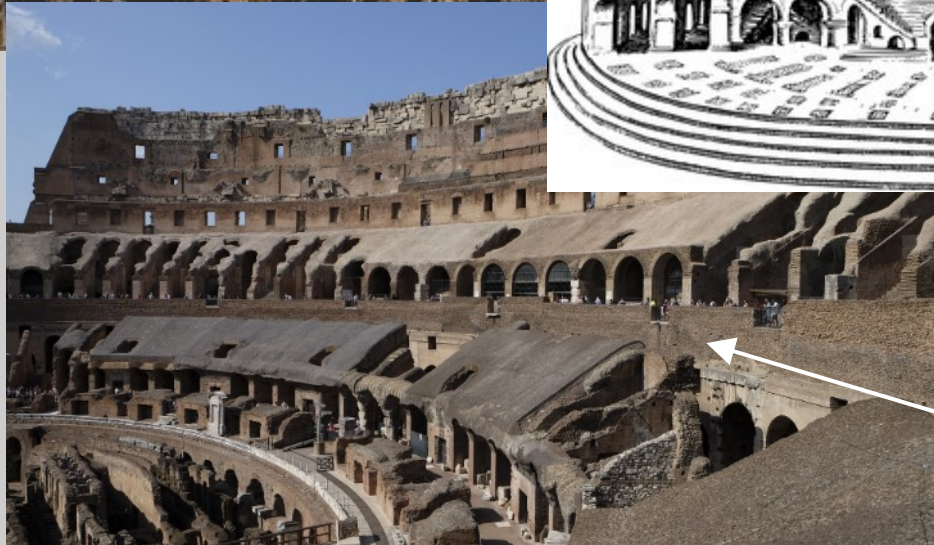
Kellerräume und Stützmauern des Arenabodens mit Aufzugkomplexen
