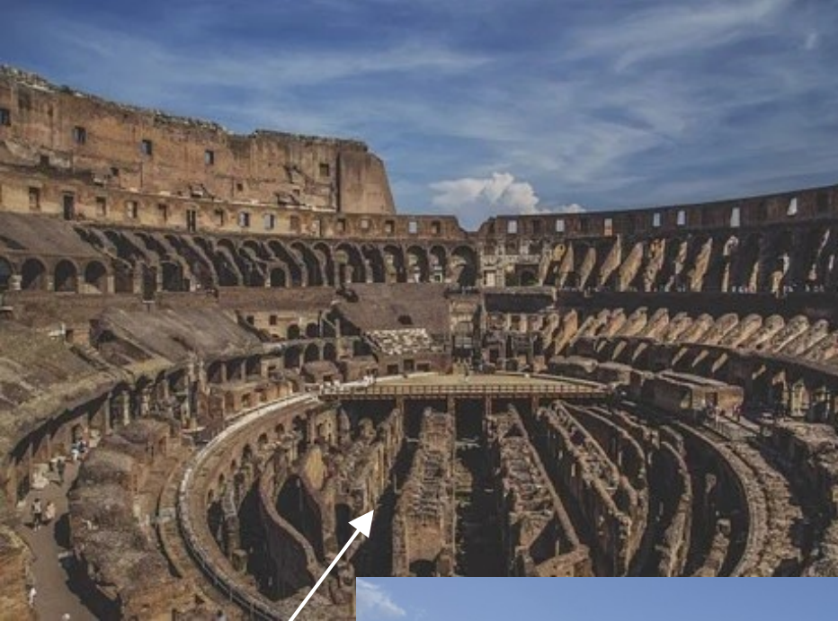
Kellerräume und Stützmauern des Arenabodens mit Aufzugkomplexen
